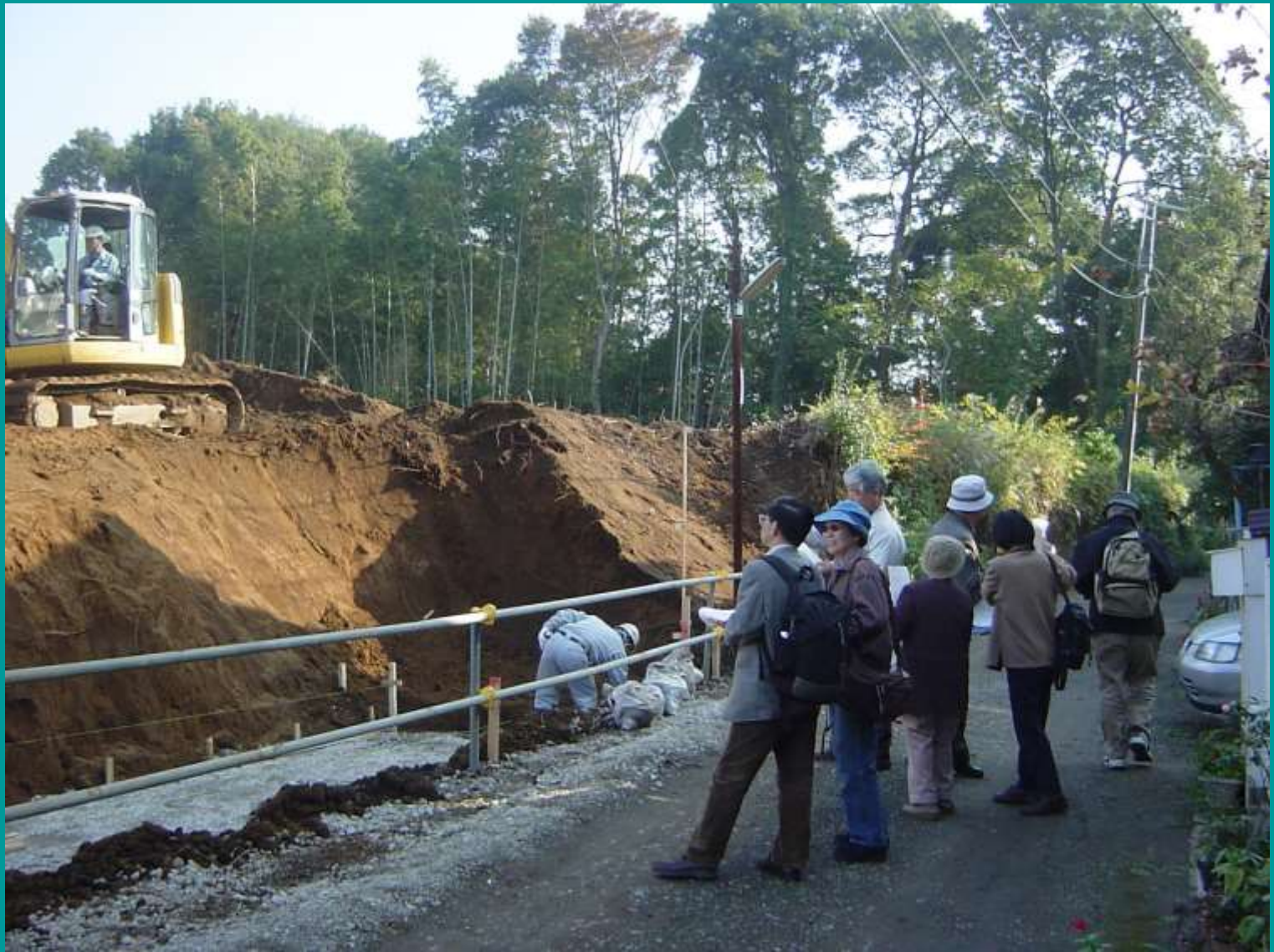
遺跡の西側の擁壁工事現場
