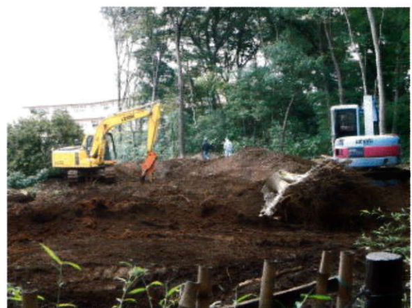
そして発掘調査現場は埋められました
